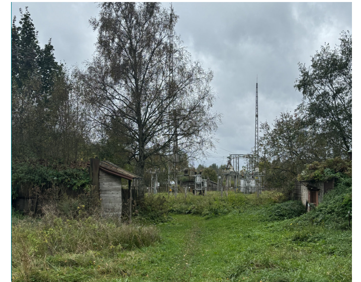
Электростанция Граничит с территорией проектирования
